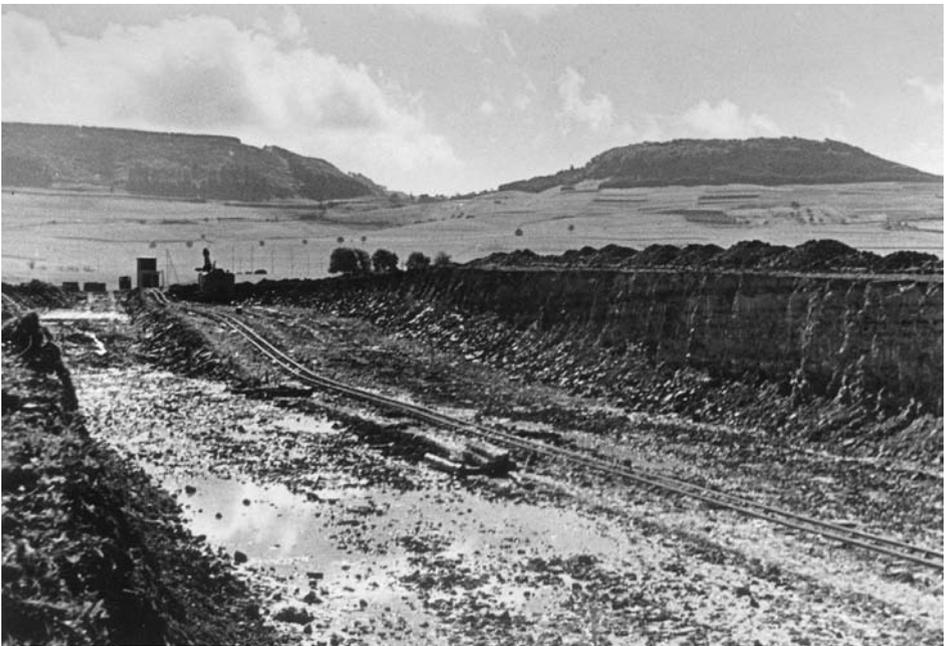
Zur Geländeeinebnung mussten Erhebungen abgetragen werden. Im Bildhintergrund rechts der Fürstenberg, links Ausläufer der Länge. In den Einschnitt zwischen den Bergen hätte ein Eisenbahntunnel für die Erzbeförderung aus den Blumberger Gruben gebohrt werden sollen. Aufnahme vom Oktober 1940. Saarstahl AG.
