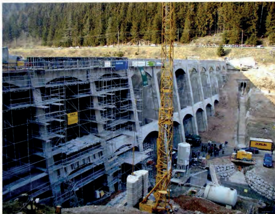
Betonsanierung der Luftseite (Stadtarchiv Vöhrenbach).
