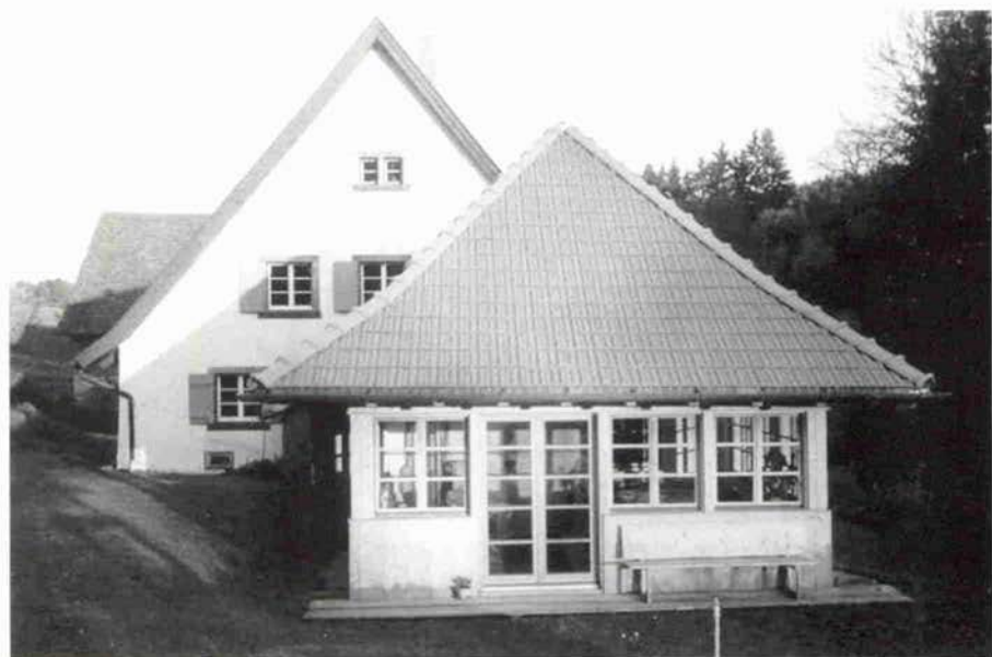
Abb. 8: Rückansicht der Guggenmühle 2001. Der Maschinenschuppen wurde umgebaut, um den rückwärtigen Giebel für Fenster frei zu bekommen. Dieselmotor und Haupttransmission sind unverändert erhalten geblieben. Vorn die Veranda in der Verlängerung des neuen Maschinenschuppens.
