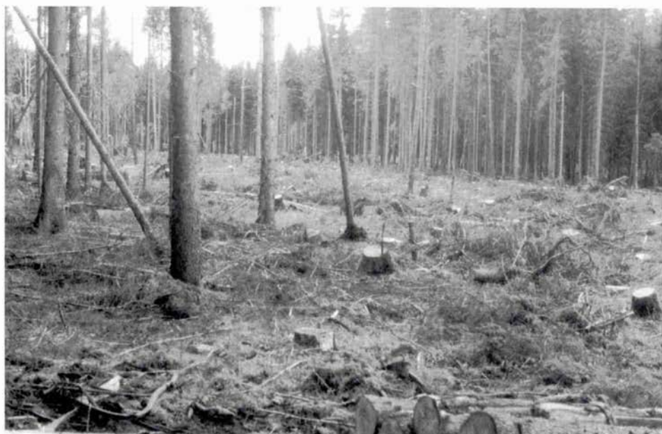
Abb. 3: Sturmschäden in einem 50jährigen Fichtenbestand auf Buntsandstein, Stadtwald Löffingen, Sept. 2000 (Foto: KINAST)
