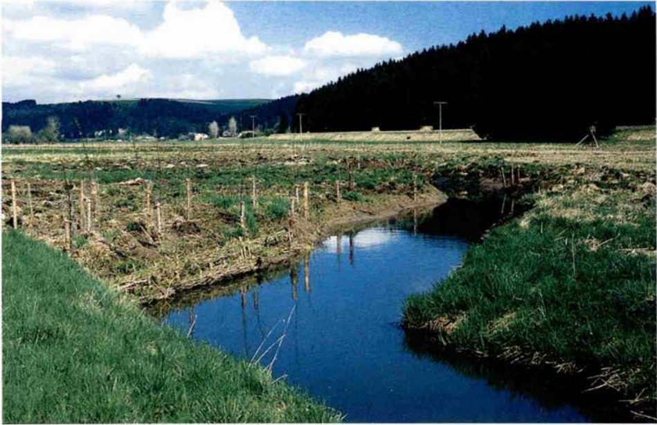
Abb. 5: (5.5.1996) Weidenfaschinen kurz nach dem Einbau.
