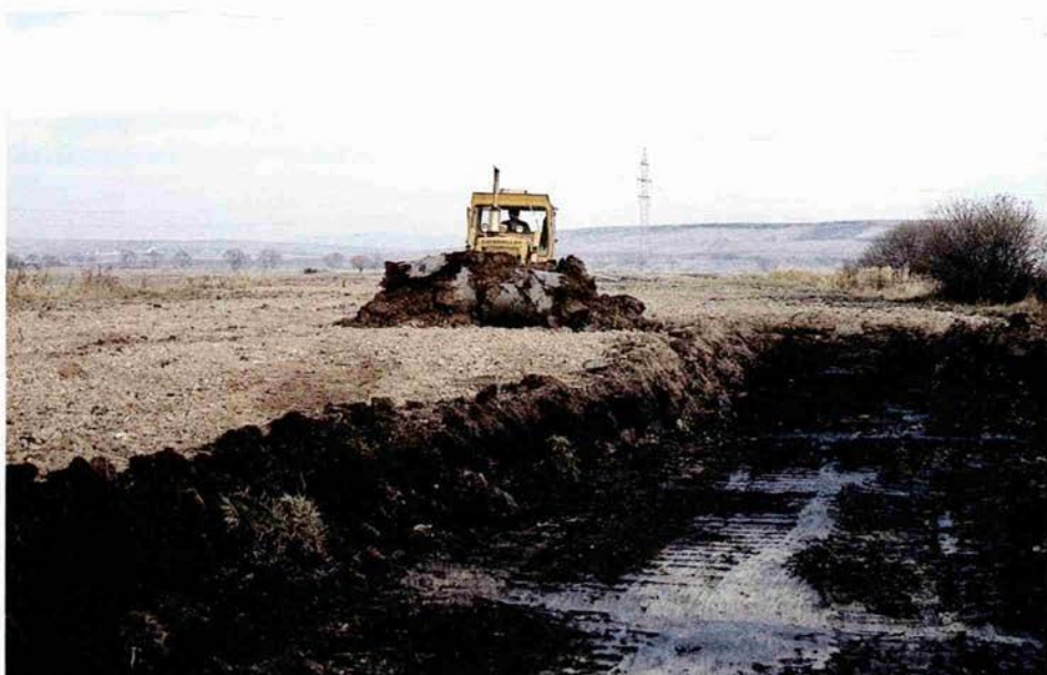
Abb. 2: Die verschüttete Riedmulde wird wieder ausgebaggert (November 1978)
