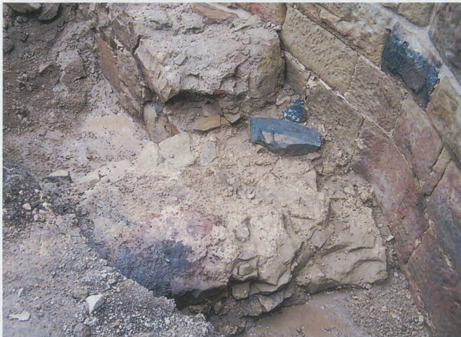
Abb. 5: Ringmauer im Süden mit Wohn-turmrest
