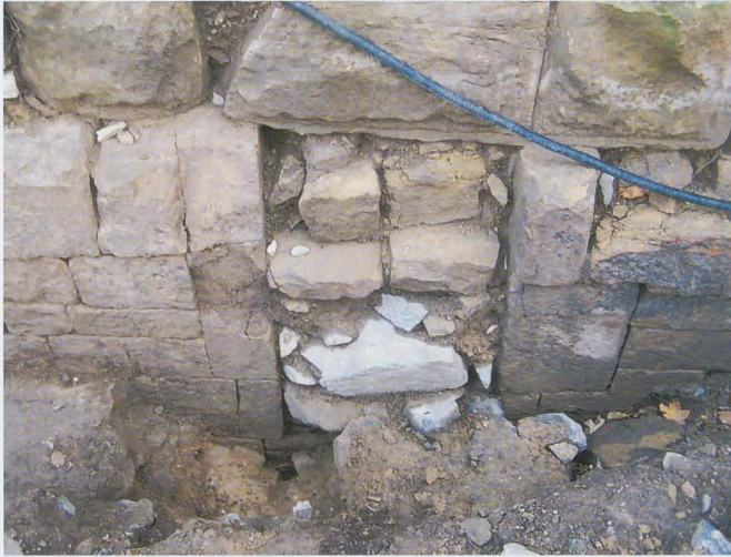
Abb. 4: Mannpforte in Ringmauer 1a
