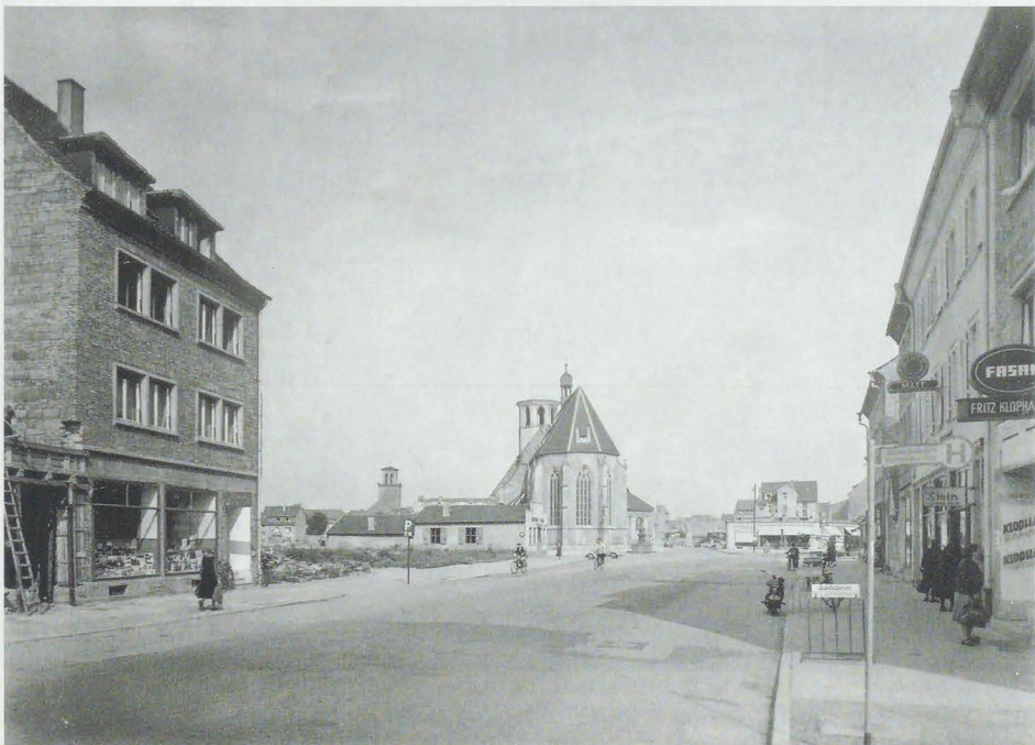
Ein leerer Platz, wo vorher und nachher das Bruchsaler Rathaus stand. Im Bildzentrum die Stadtkirche Unsere Liebe Frau.
