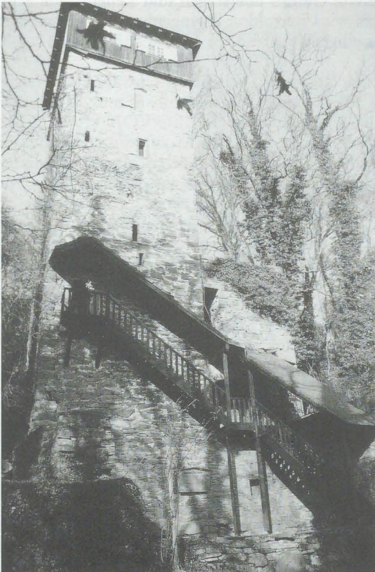
Abb. 3: Der bewohnbare Turm; Zustand Frühjahr 2005
