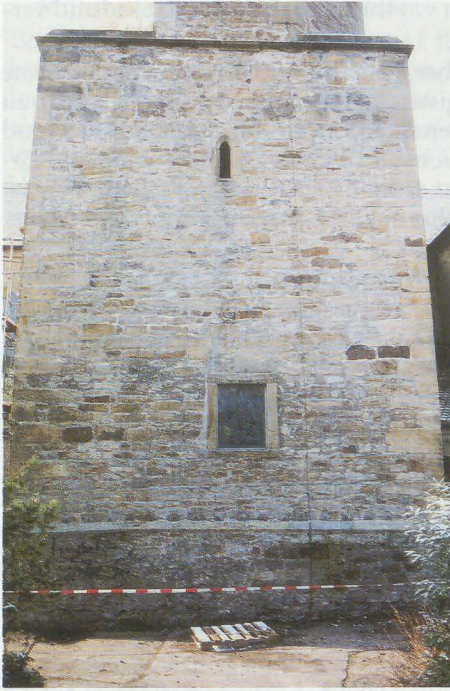
Abb. 1: Der Kirchturm von Osten; das untere Fenster ist noch zugesetzt
