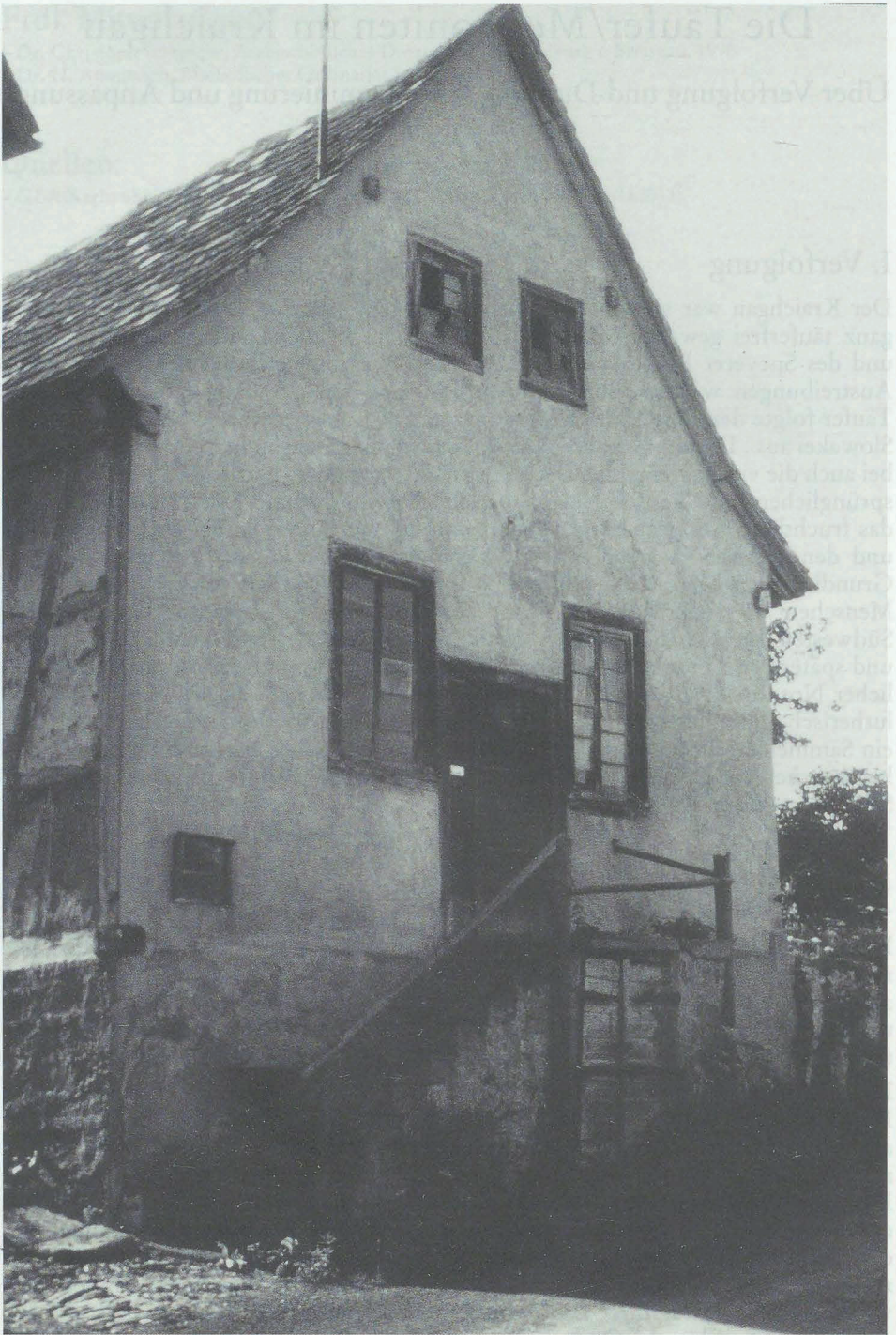
Abb. 1: Altes Gemeindehaus in Immelhausen, erbaut etwa 1700, Versammlungsort für Ältesten-, Prediger- und Diakonenversammlungen bis ca. 1900
