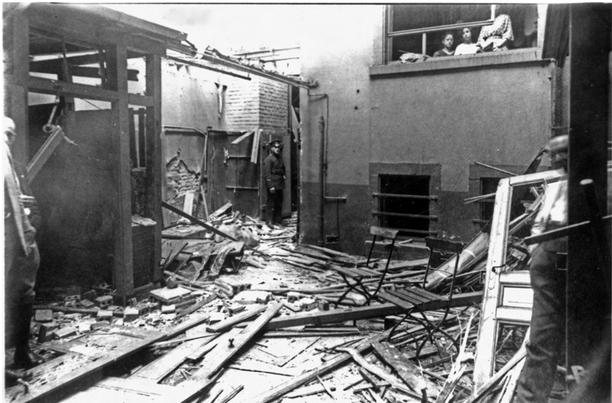
Zwei Fotos die die Schäden, des Bombenanschlags auf das Mannheimer Volkshaus zeigen. (Nachlass Lothar Steinbach Zug. 56/2020, Teil D 5, (noch unverzeichnet) MARCHIVUM)
