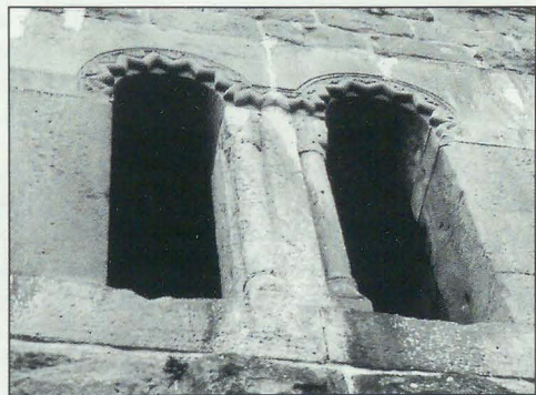
Abb. 3: Vergleichbar sind die Doppelfenster im Erdgeschoss des Palast der Burg Wildenberg. Sie sind nicht nur ähnlich dimensioniert, sondern besitzen auch den Zickzack-Fries, wie eines der Hornberger Fenster. Und ihre Rundbögen sind ebenfalls aus einem Steinbruch herausgearbeitet.
