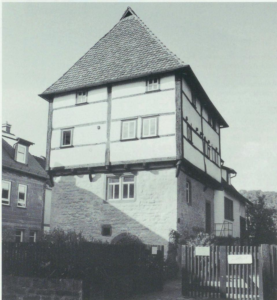
Abb. 4: Amorbach, sog. Templerhaus (1998). Steinerne Unterbau (2. Hälfte 12./frühes 13. Jh.), hölzerner Aufbau (1291).
