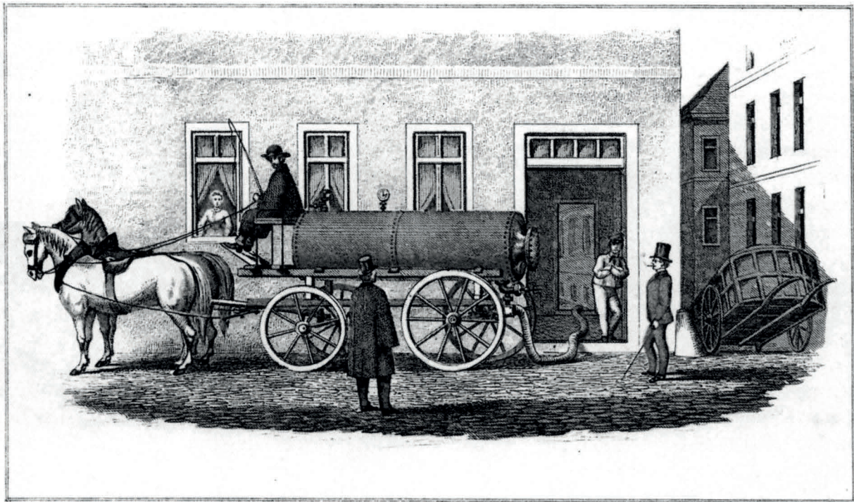
Abb. 1 Pneumatische Entleerung einer Abtrittgrube, zeitgenössische Darstellung (StadtAF, C1 Polizeisachen 9 Nr. 1).
