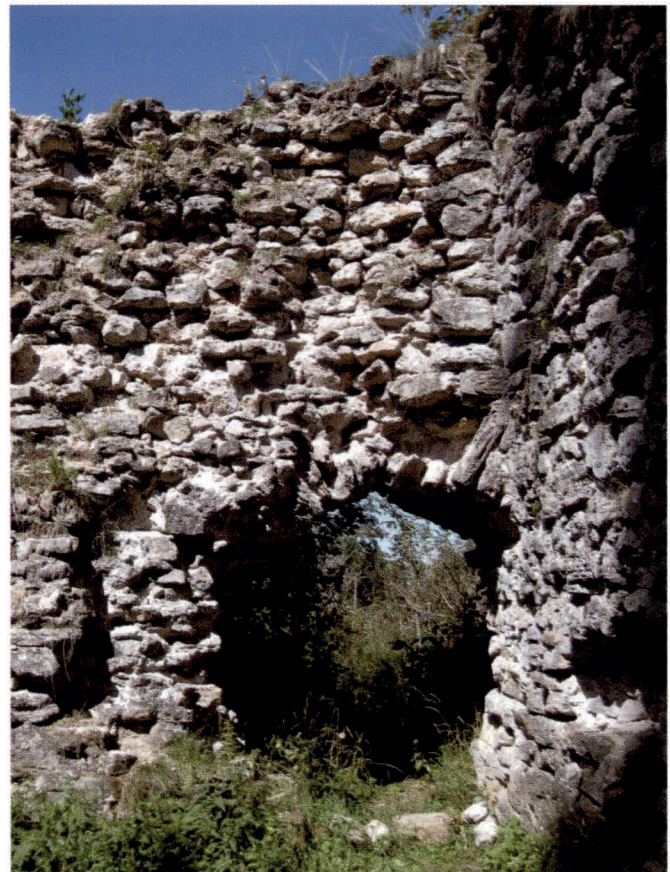
Abb. 10 „Burgruine Dellingen“. Nordwand des Turmes (innen) mit ebenerdiger Tür (Foto: Heiko Wagner).
