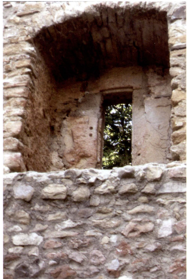
Abb. 9 Nordwestliche Ecke der Schneeburg. Fenster im 1. Obergeschoss mit Gewände und originale Verputz (Foto: Heiko Wagner 2002).
