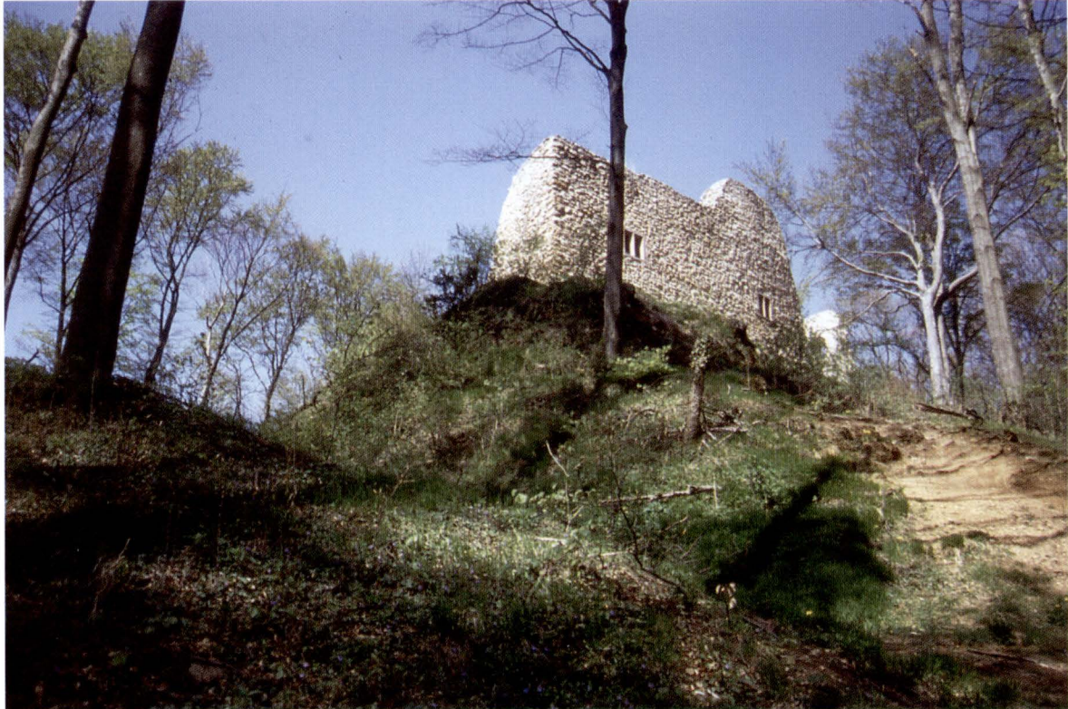
Abb. 3 Die Burgruine Schneeberg von Südosten. Links der Graben mit dem Vorwall (Foto: Heiko Wagner 2003).
