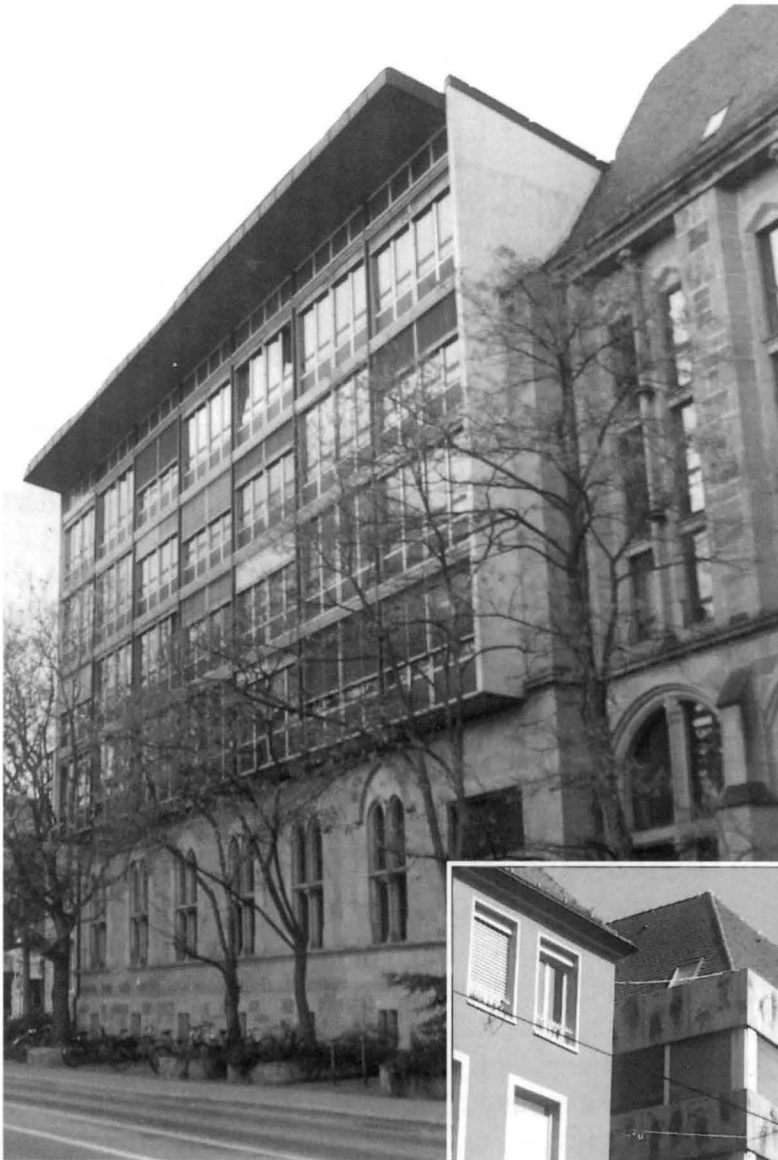
Abb. 9 Nicht unumstritten war der Verzicht auf den Wiederaufbau des zerstörten Südflügels der Alten Universitätsbibliothek (Photo des Autors)
