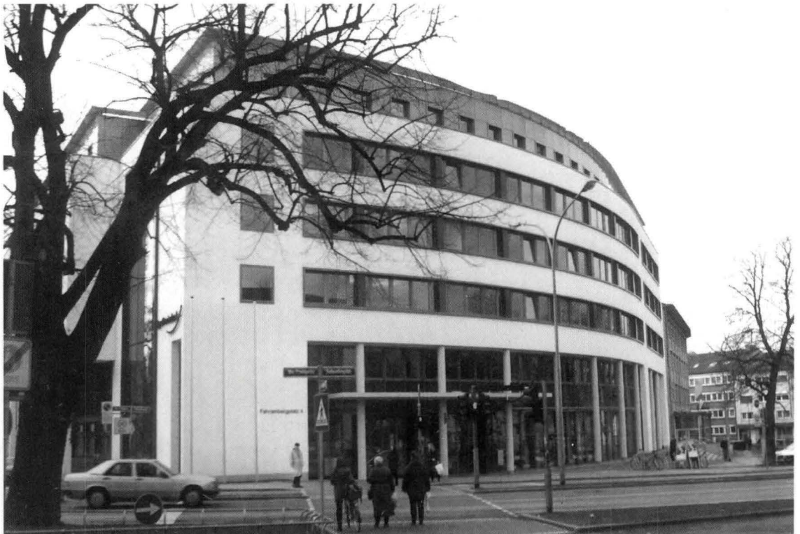
Abb. 14 Behördenneubau am Fahnenbergplatz (Photo des Autors)
