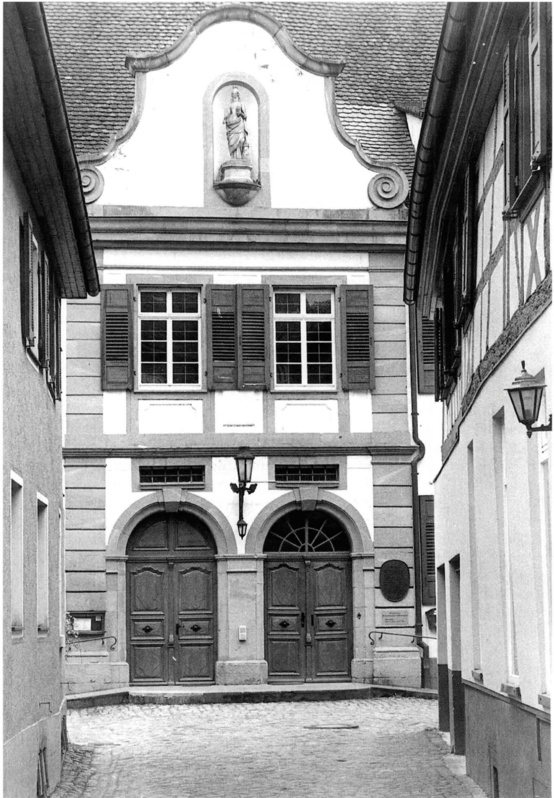
Abb. 2 Die barocke Eingangsfassade des Spitals (Stadtarchiv Freiburg, Photo Corcodel)
