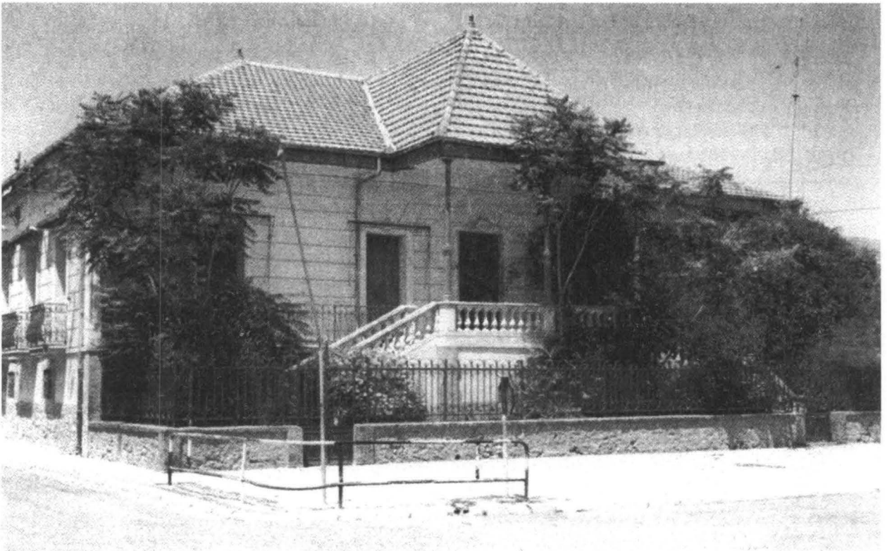
Abb. 3 Haus eines Auswanderers in Sidi-Khaled. An diesem um 1910 erbauten Haus kann man sehen, dass es mancher Siedler zu beträchtlichem Wohlstand gebracht hat (Freunde der Geschichte Heimbachs, Hans-Bernhard Kradepohl)
