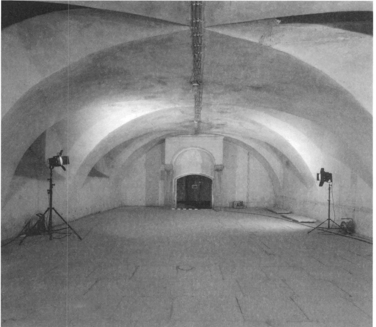
Abb. 8 Archivgewölbe im Erdgeschoss des Flügelbaus (1730/31), im Hintergrund der heute wieder offene Zugang zum Kapellenkeller und darüber die baldachinartige Unterkonstruktion des Treppenpodests zur Kapellentür im Obergeschoss (LDA, Außenstelle Freiburg, Bildarchiv)
