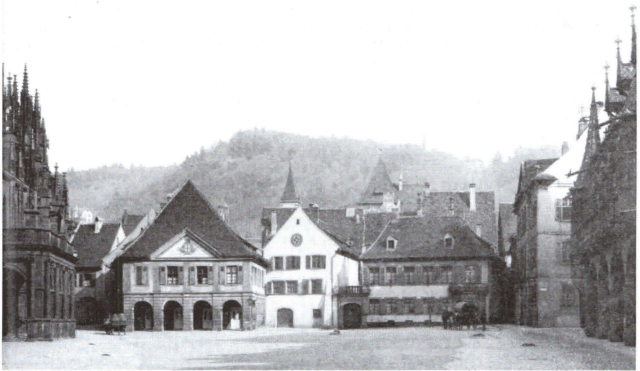
Abb. 1 Die Südostecke des Freiburger Münsterplatzes. Das Gebäude mit spitzem Giebel ist die Kooperatur, links die Alte Wache, ganz rechts das Wentzingerhaus und das Historische Kaufhaus (Aufnahme von 1906; Augustinermuseum Freiburg, Denkmälerarchiv)
