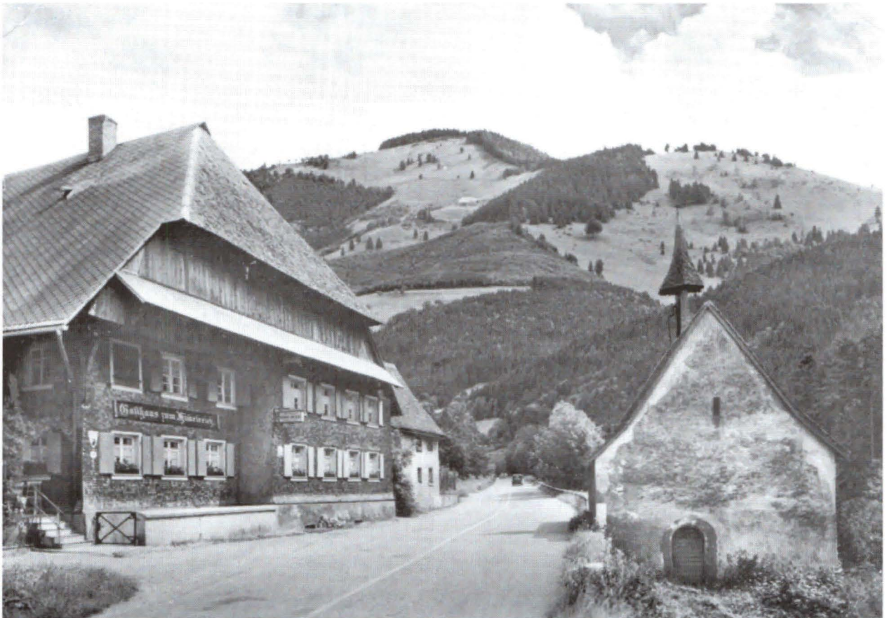
Abb. 3 Das in Teilbereichen modernisierte Gasthaus „zum Himmelreich“ mit der Jakobuskapelle an ihrem ursprünglichen Standort um 1950. Die Kapelle wurde zwischenzeitlich zweimal versetzt und befindet sich nun auf der gegenüber liegenden Straßenseite, links neben dem Gasthaus (Nienhaus)
