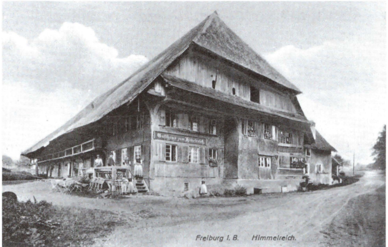
Abb. 1 Das Gasthaus „zum Himmelreich“ am Eingang des Höllentals in Kirchzarten-Burg um 1900. Das kaminlose Dach ist noch vollständig mit Holzschindeln gedeckt (Nienhaus)
