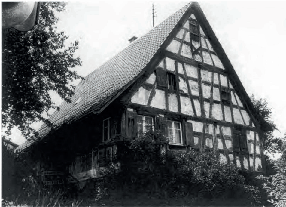
Abb. 2 Giebelwand des Klosterhofs vor der Restaurierung. (Bildvorlage der Autorin)
