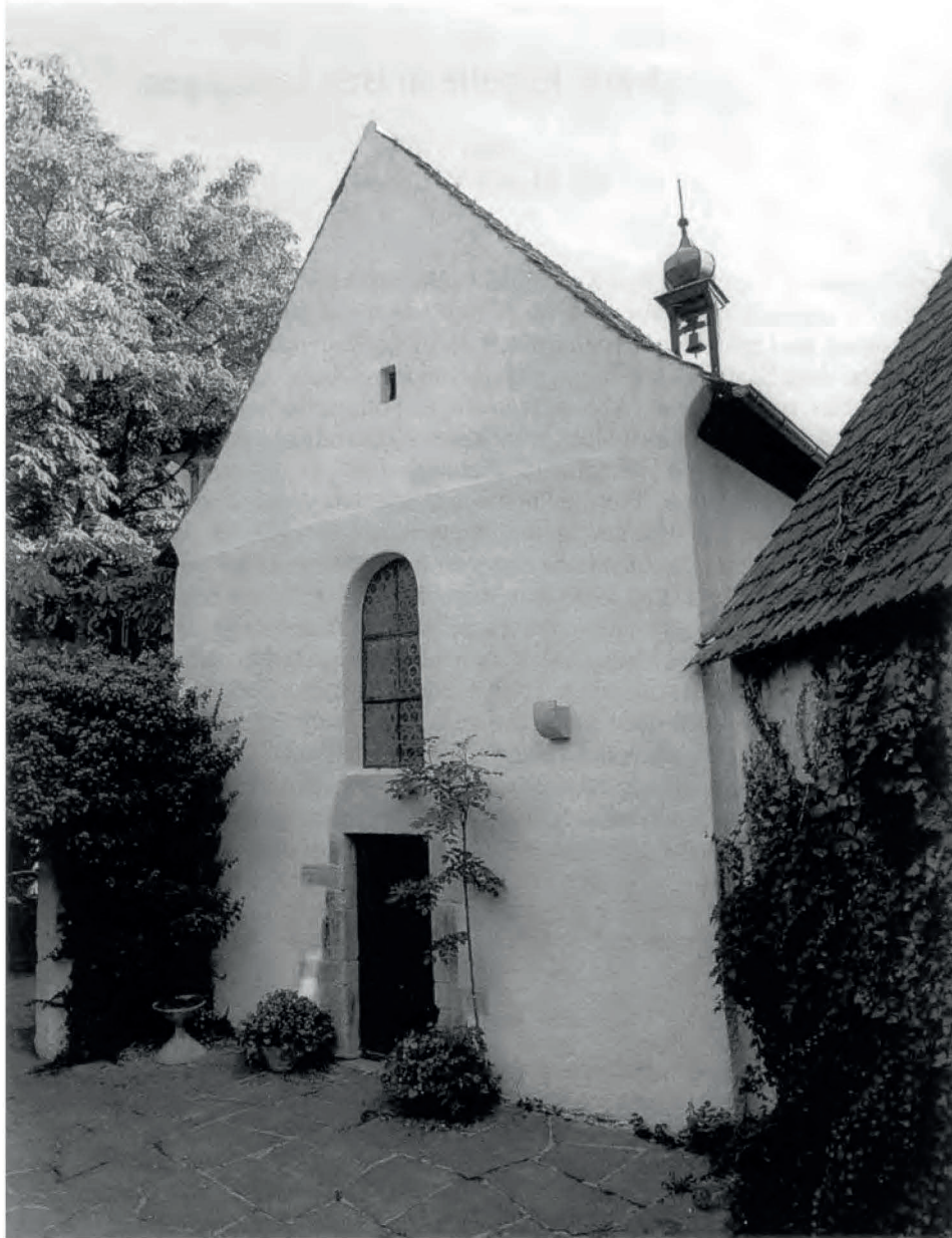
Abb. 1 Ansicht der Glöcklehof Kapelle von Südwesten nach der Neuverputzung 1993. (Photo J. Jeras, Gündlingen)
