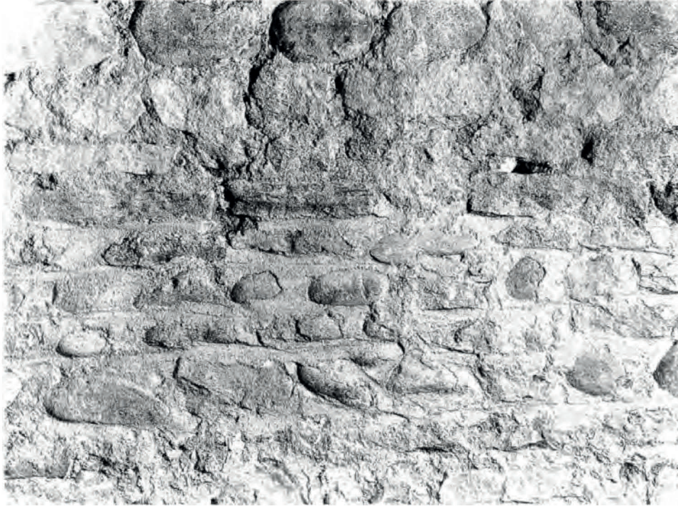
Abb. 5 Detail der Chorostwand mit Pietra Rasa Befund. (Photo J. Jeras, Gündlingen)
