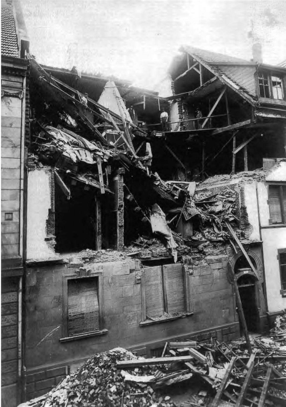
Abb. 3 Beim Fliegerangriff am 17. August 1917 zerstörtes Haus Rosastraße 7a. (StadtAF, M 7061)
