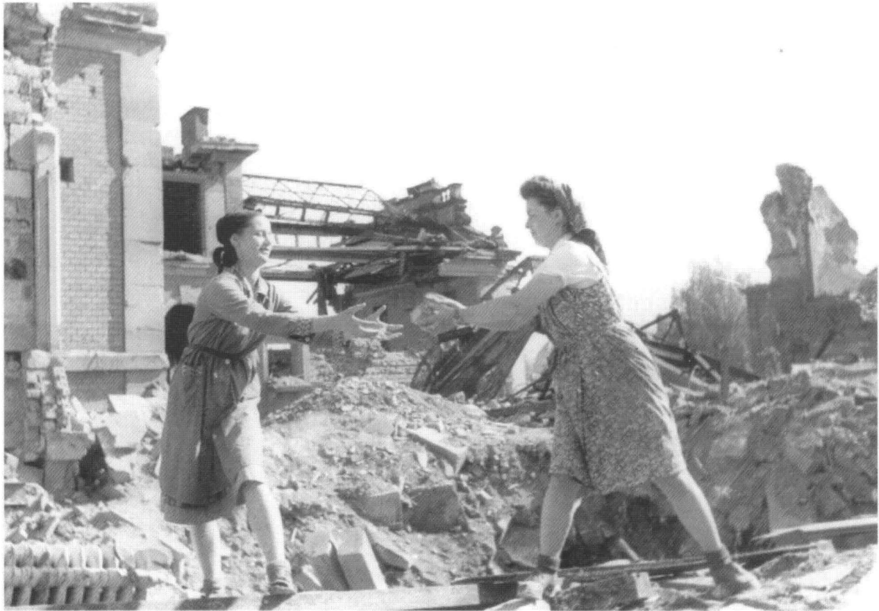
Abb. 2 Trümmerfrauen bei Aufräumarbeiten im Institutsviertel (StadtAF, M 75/1 Positivkasten 14)
