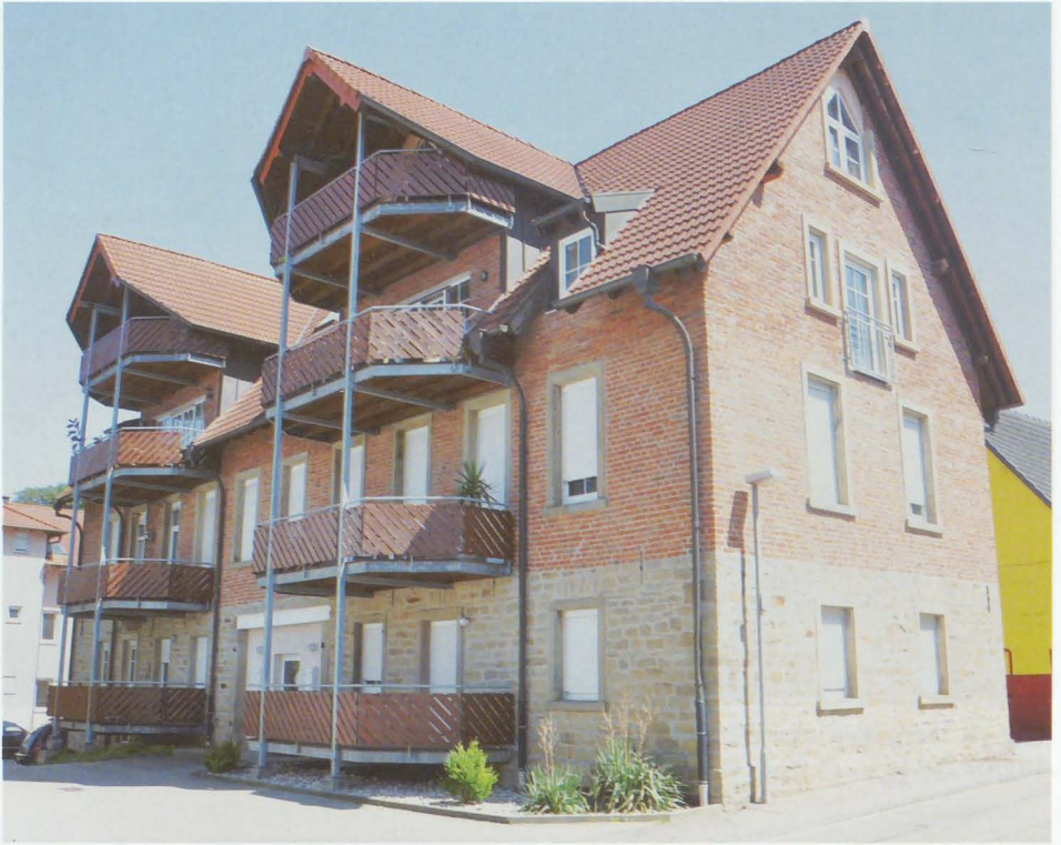
Abb. 9: Zum Wohnhaus umgebaute ehemalige Zigarrenfabrik der Firma Gebrüder Hagmaier in der Hildastr. 31 in Michelfeld im August 2011. Typisch sind der Schilfsandsteinsockel und die aus Ziegelsteinen gemauerten Stockwerke mit ihren langgezogenen Fensterreihen.
