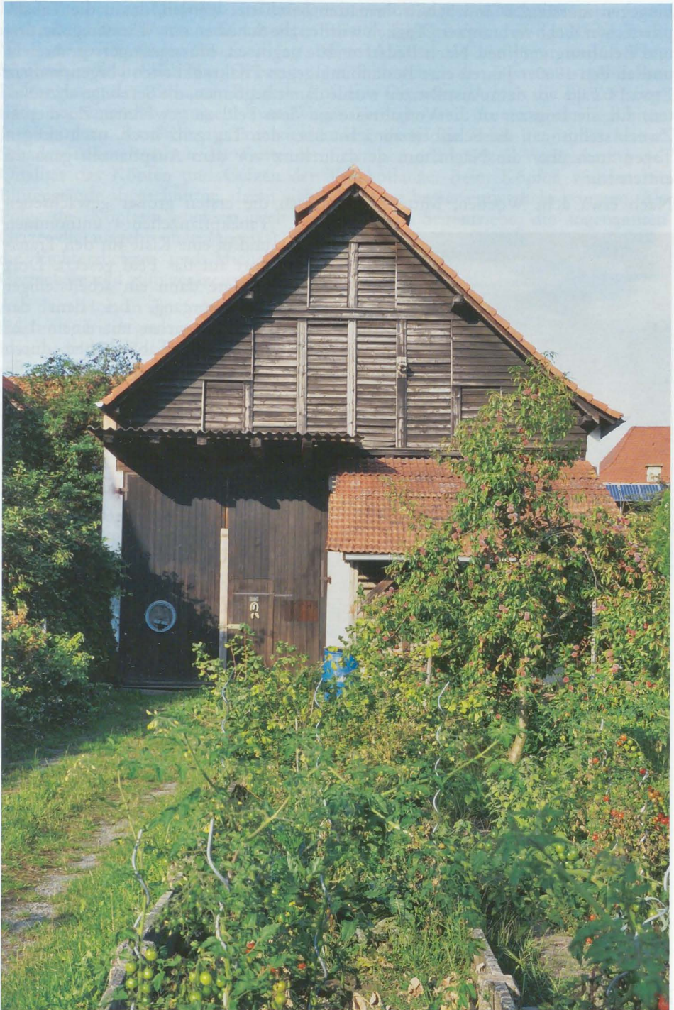
Abb. 3: Ehemaliges Tabakfrühbeet (Vordergrund) von Karl Krotz hinter dem 1957 gebauten Tabakschuppen in der Hauptstraße 25 in Eichersheim.
