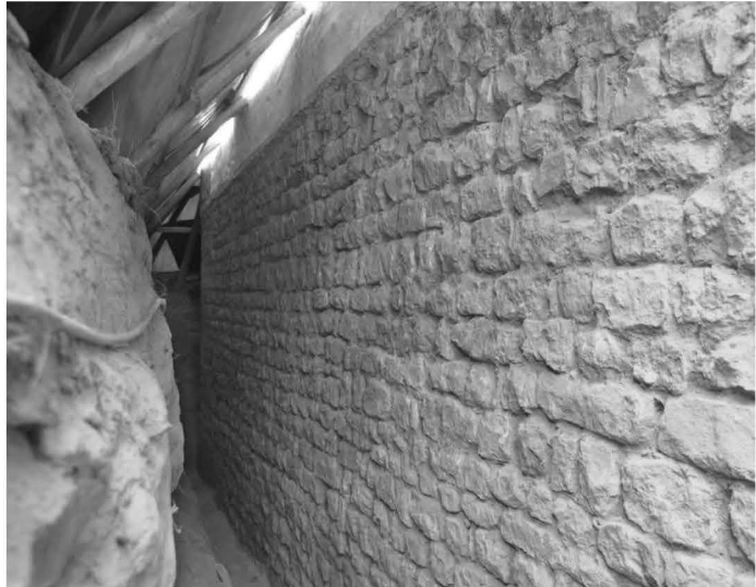
Abb. 4 Riegel, Michaelskapelle. Mauerstruktur auf der nördlichen Außenseite des Langhauses während der Freilegung 2008 (Foto: King).
