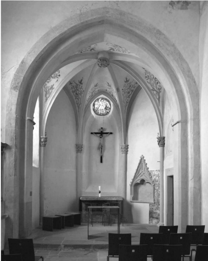
Abb. 11 Riegel, Michaelskapelle. Blick in den Chorraum nach der Restaurierung 2008/09 (Foto: King).
