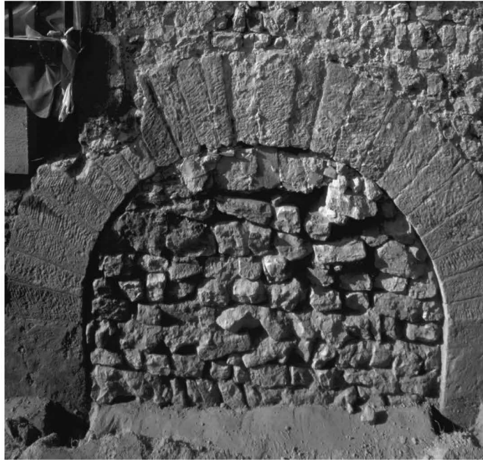
Abb. 6 Riegel, Michaelskapelle. Ansicht des vermauerten rundbogigen Portals in der Nordwand (Foto: Wagner/Jenisch).
