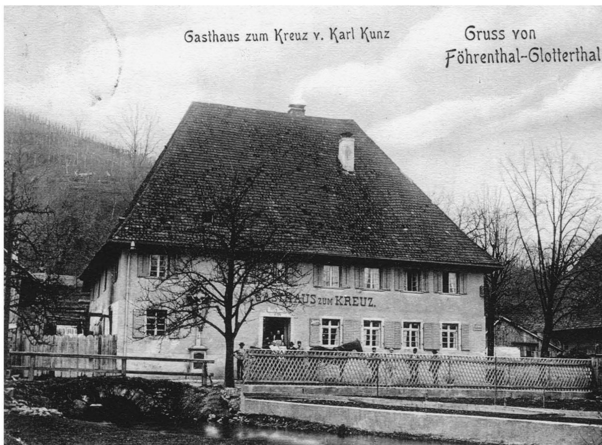
Abb. 2 Das Gasthaus „Zum Kreuz“ in Föhrental. Bis um 1900 waren hier das Rathaus, die Amtsstube und das Ratszimmer untergebracht (Schröer).
