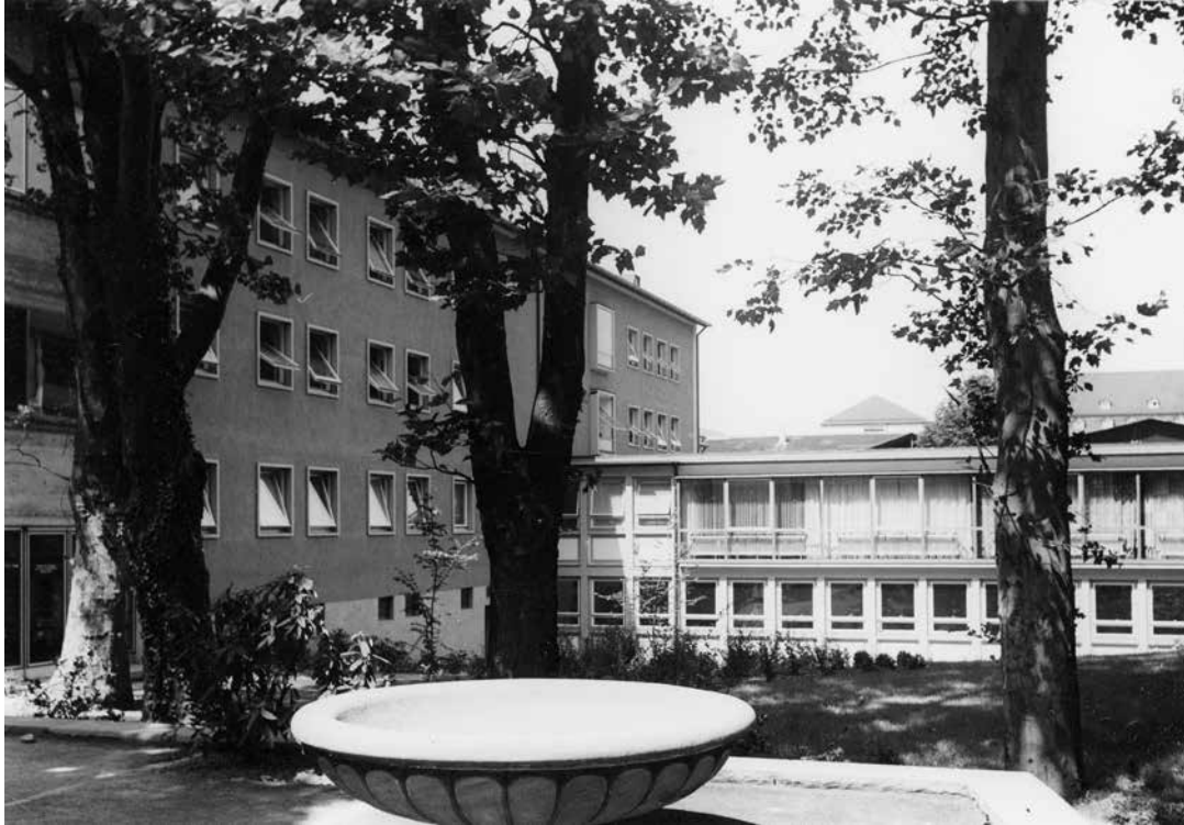
Abb. 2-4 In den 1950er-Jahren in Freiburg neu erbaute Alten- und Pflegeheime: Das Vinzentiushaus in der Friedrichstraße, das Evangelische Stift in der Hermannstraße und das Heiliggeiststift in der Deutschordensstraße (StadtAF, M 75/1 Pos. K. 3).
