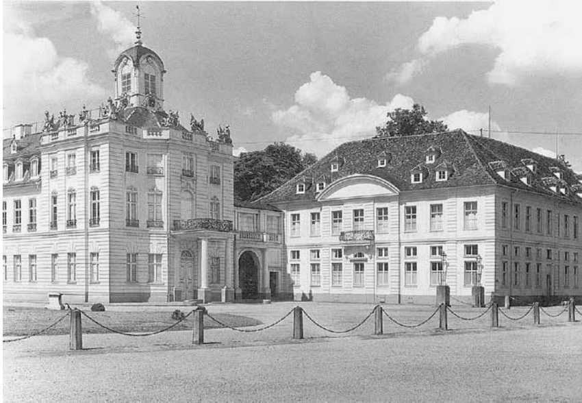
23 | Karlsruhe, Östliches Nebengebäude des Schlosses von Albrecht Friedrich von Kesslau. Fotograf unbekannt. Um 1930. Landesamt für Denkmalpflege Karlsruhe, RP KA 3793
