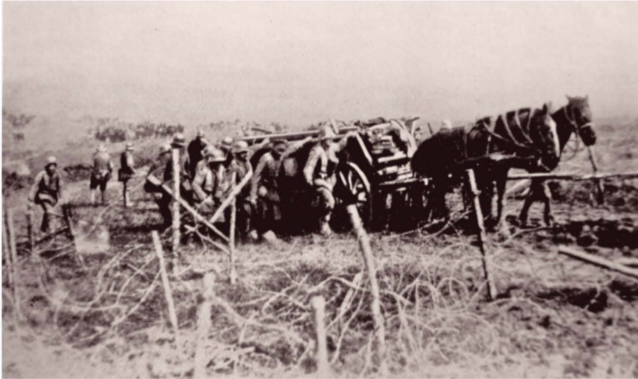
Materialtransport zum Stellungsbau.
