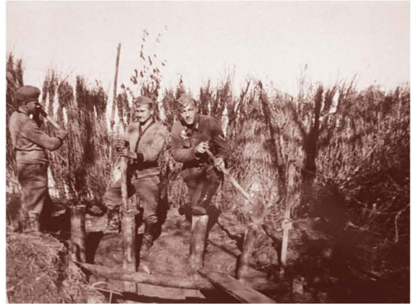
Tarn- und Sicherungsarbeiten
