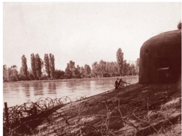
Bunker der ersten Linie direkt am Rheinufer mit sieben Mann Besatzung (infanteristische Gruppe)
