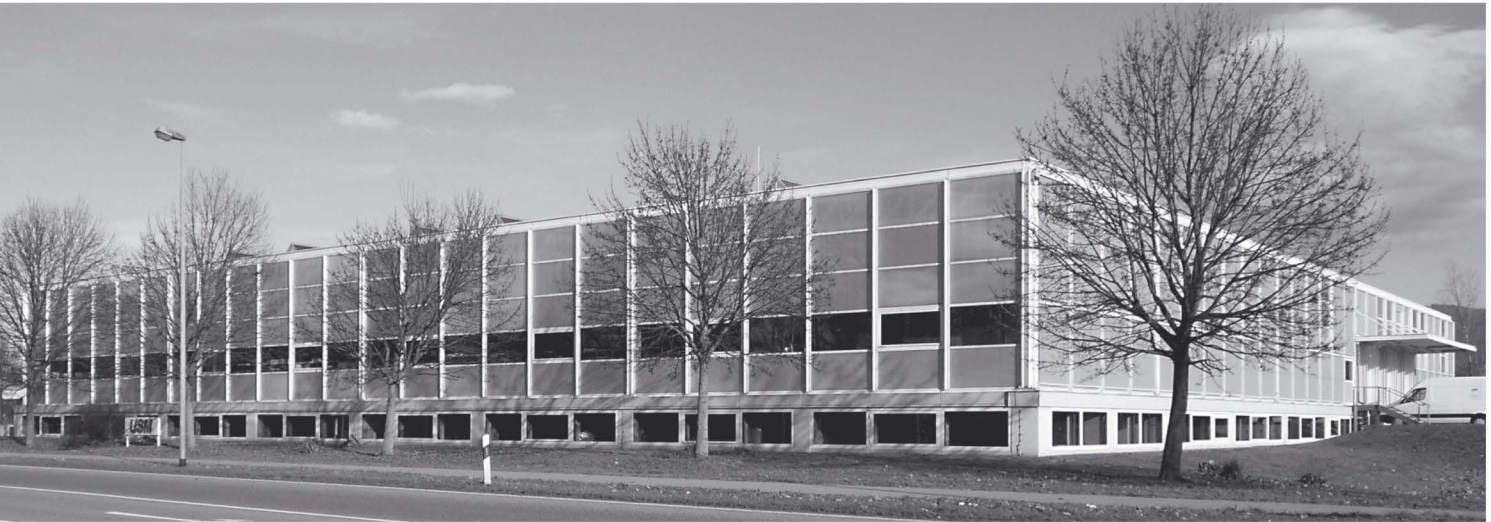
USM-Betriebsanlage in Bühl, Ansicht von Südwesten. (Foto: Coenen)
