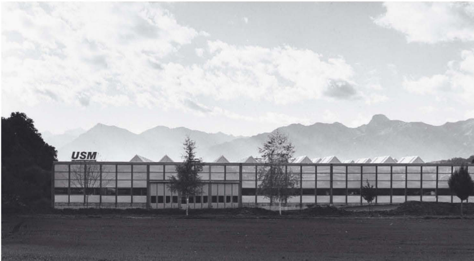
USM-Betriebsanlage in Münsingen. (Foto: USM)
