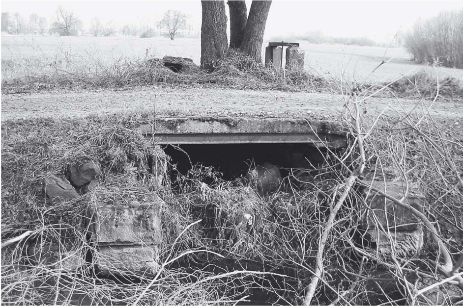
Reste einer Stellfalle am ehemaligen Stahltrog über den Bruchgraben
