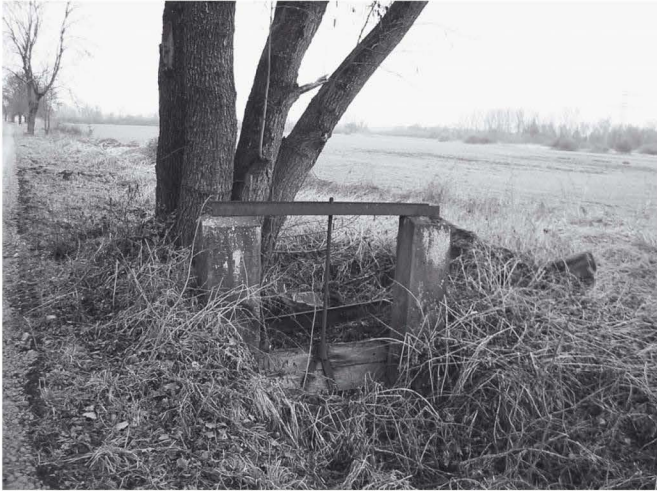
Stellfalle zur Aufstauung und Umleitung des Wassers
