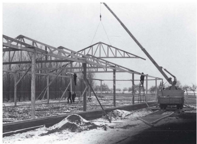
1965/1966 Bau der Schreinerei mit Teleskopkran
