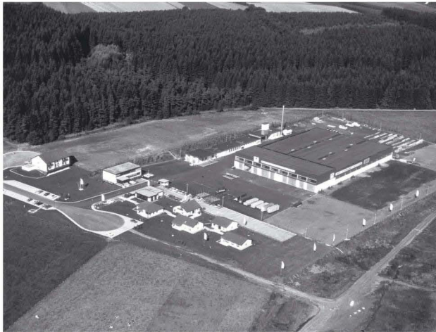
Bild rechts: Bau des zweiten Werkes im Sauerland, Wenden- Hünsborn 1978
