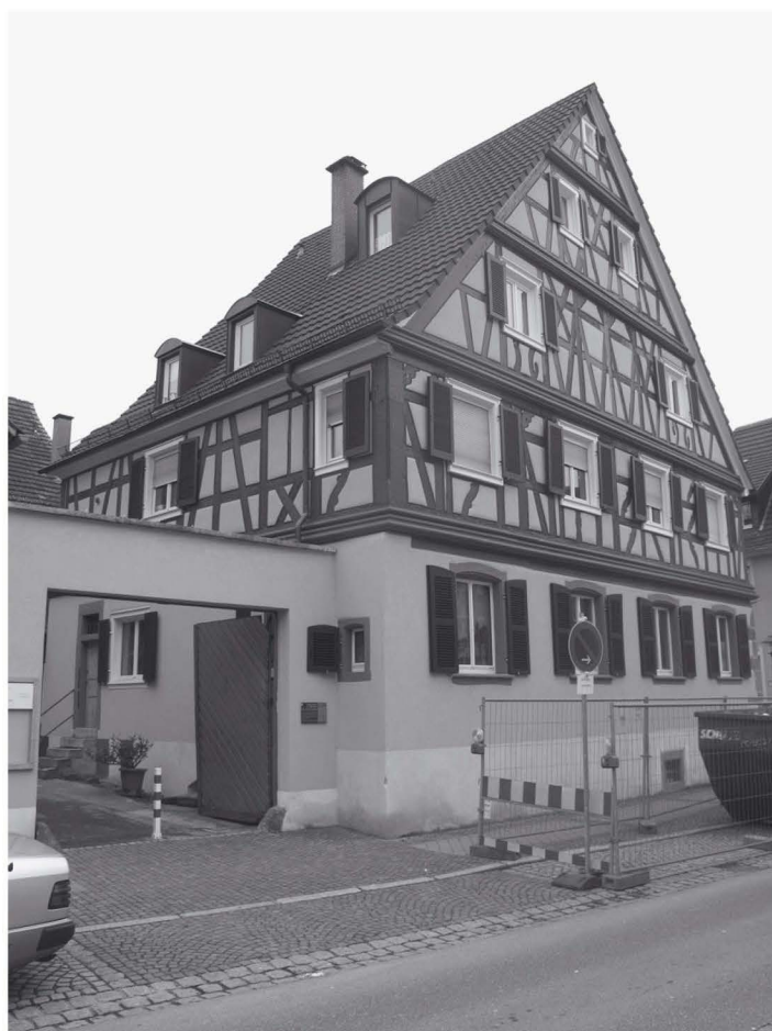
Abb. 2: Haus Gymnasiumstr. 1/ Ecke Gerberstraße, Offenburg. Zustand 2010. Foto Ruch
