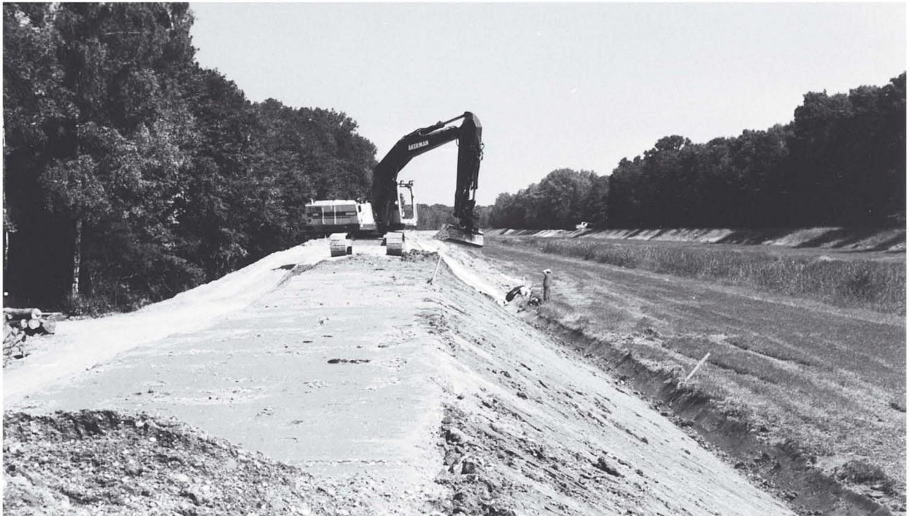
*Abb. 8: Deichsanierung am Renchflutkanal bei Wagshurst (1999)*
