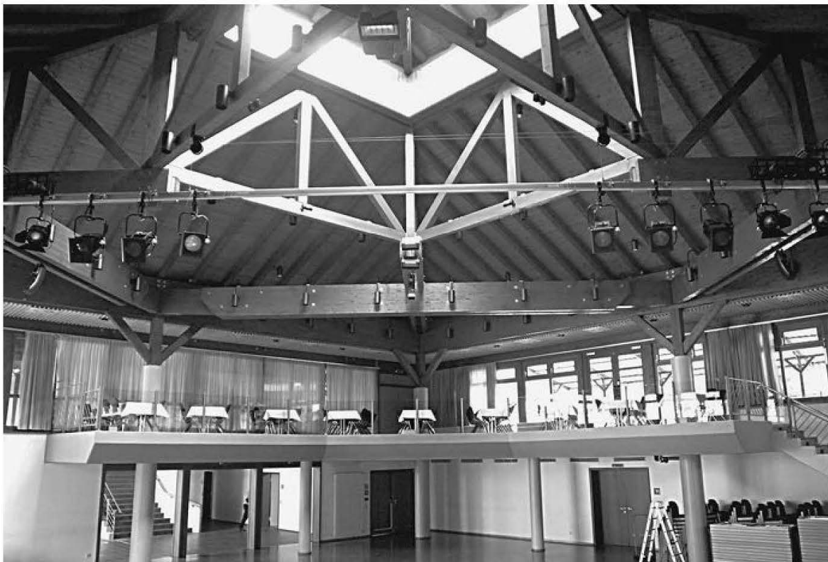
Großer Saal (Zustand: 2008)
