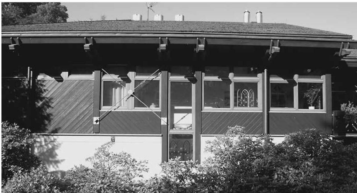
Fassade gegen die Bühlot (Detail) (Zustand: 2008)
