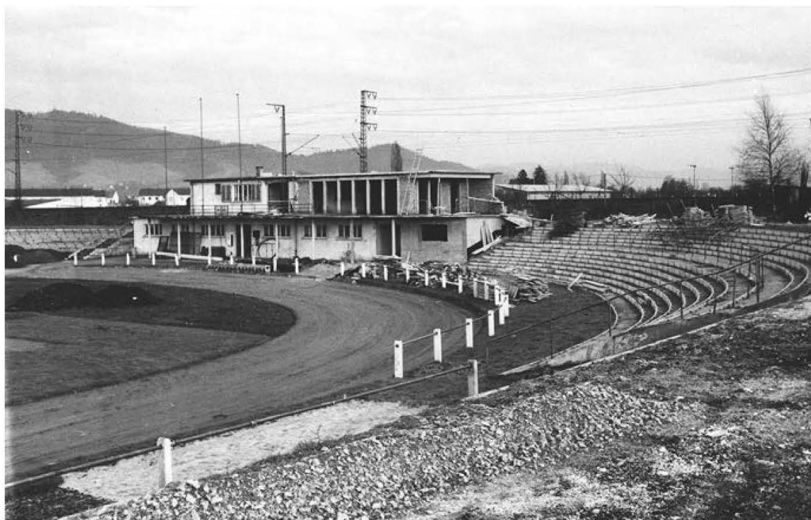
Turnerheim und Stehtribünen entstehen
