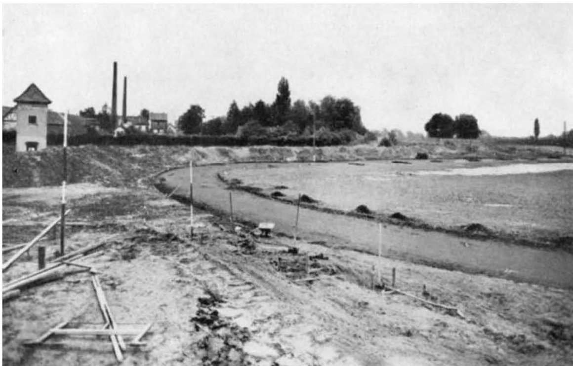
Aschenbahn und Zuschauerwälle im Bau
