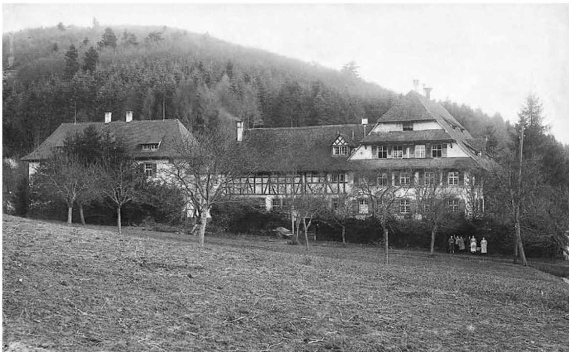
Originalaufnahme des Trettenhofes
