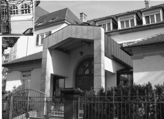
Der umgestaltete Eingangsbereich
