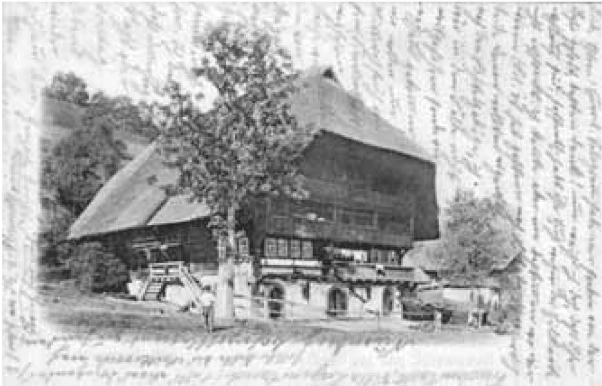
Bild 1: Der im Jahre 1922 abgebrannte Dorfbauernhof in Hausach-Dorf um 1900: ein typisches zweigeschossiges Kinzigtäler Haus in der Konzeption, wie sie für diesen Haustyp ab etwa dem 18. Jahrhundert üblich war. Der relativ große Speicher – am rechten Bildrand schwach zu erkennen – wurde 1885 errichtet, siehe auch Bilder 3 und 3a.
