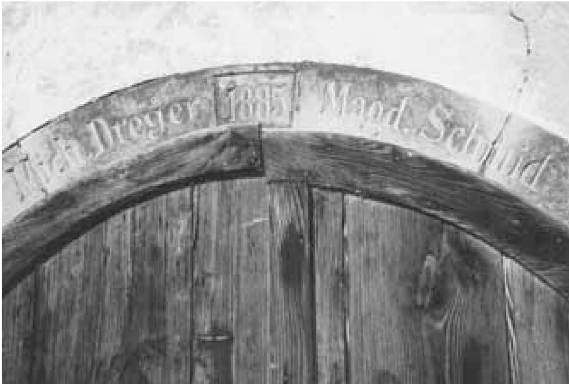
Bild 3a: Der sandsteinerne Torbogen des Speichers mit den Namen der Erbauer und der Jahreszahl 1885.
