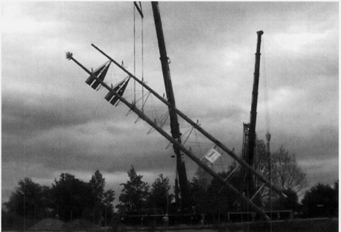
Der Turm wird in die Vertikale gebracht
