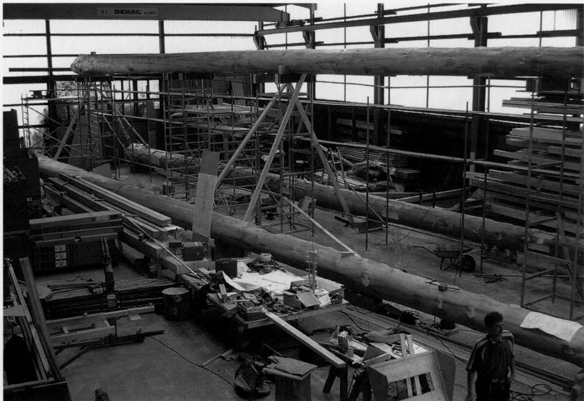
Die Stämme werden in der Zimmerei vormontiert
