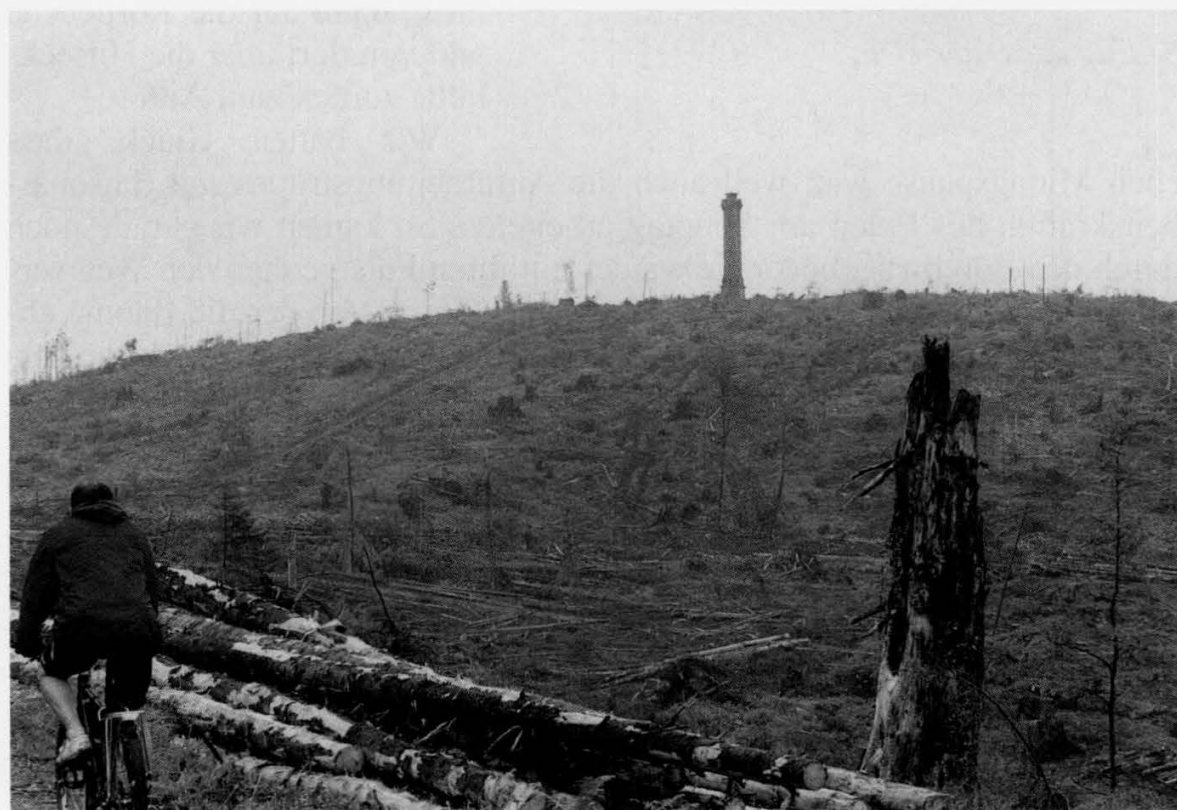
Moosturm nach Aufarbeitung des Sturmholzes
