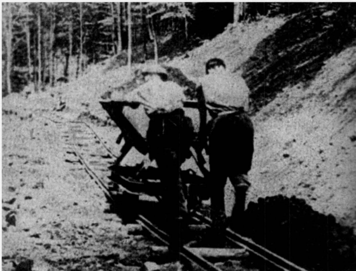
Noch erfolgt der Erdtransport beim Waldwegebau auf der Lore
