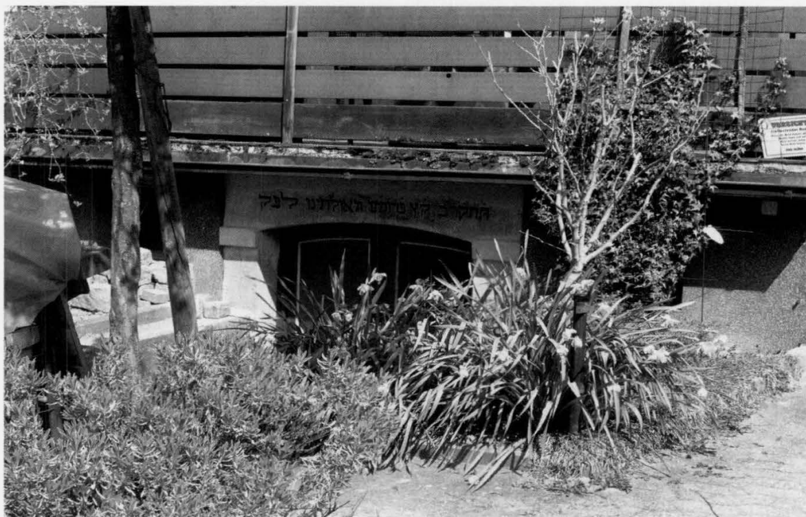
Haus Strittmatt 4, historisches Gemeindehaus
