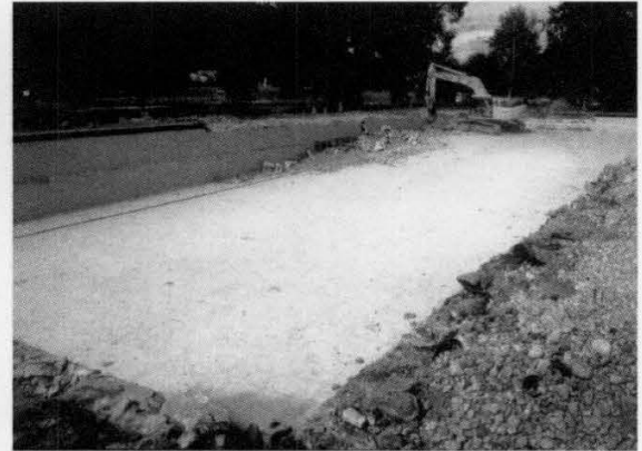
Abriss des Schwimmbeckens im Jahre 2002
