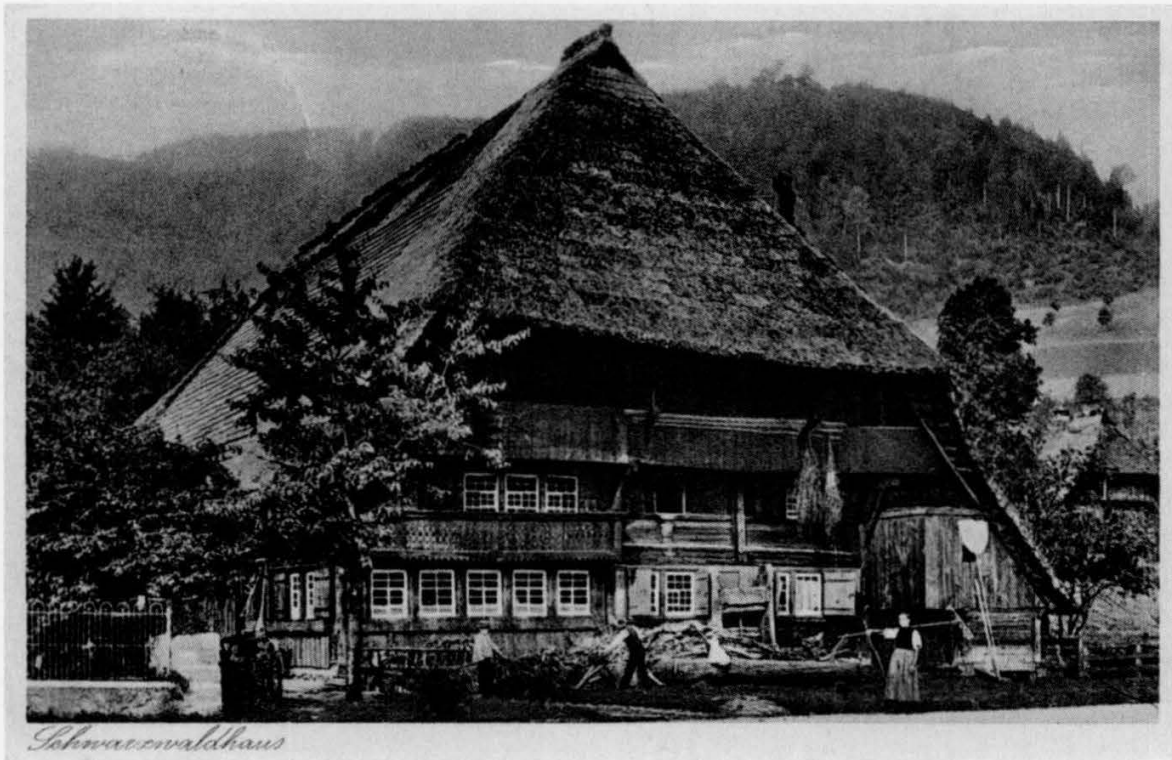
Bild 12: Auch beim 1769 erbauten dreiraumbreiten Bachbauernhof in Gutach – Foto um 1900 – entspricht die Raumaufteilung nicht der des Gutacher oder Gutachtäler Hauses nach Schilli oder Schnitzer. Der Wohnungsgrundriss dieses Hauses ist prinzipiell identisch mit dem des Peterbauernhofs am Turm.
