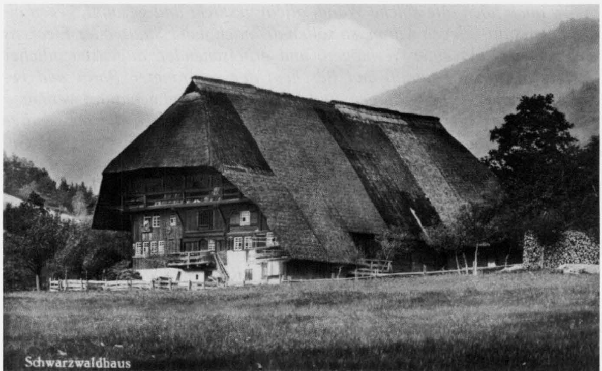
Bild 7: Auf dem um 1900 entstandenen Foto des um 1680 erbauten und 1914 abgebrannten Hinterschlauchbauernhofs in Gutach – einem typischen Gutachtäler Haus – ist keine Fachwerkwand in der Hausfront zu sehen. Auch im Bereich der Rauchküche – etwa in der Mitte der Giebelseite des Hauses – ist die ursprüngliche Ständer-Bohlenbauweise gut zu erkennen. Oberhalb der Küchentür am vorgelagerten Kucheneingang ist das Rauchgatter sichtbar, durch das ein Großteil des Rauchs vom Küchenherd und Kachelofen ins Freie gelangte; der Rest zog über den Dachraum und das Strohdach ab.
