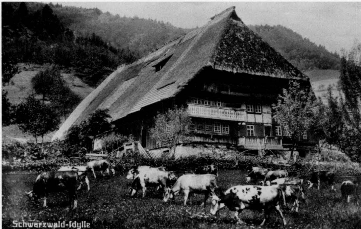
Bild 3: Auch beim 1933 abgebrannten Wäldebauernhof in Gutach ist die helle Fachwerkaußenwand der Küche in der Giebelseite gut zu erkennen – Foto um 1900.
