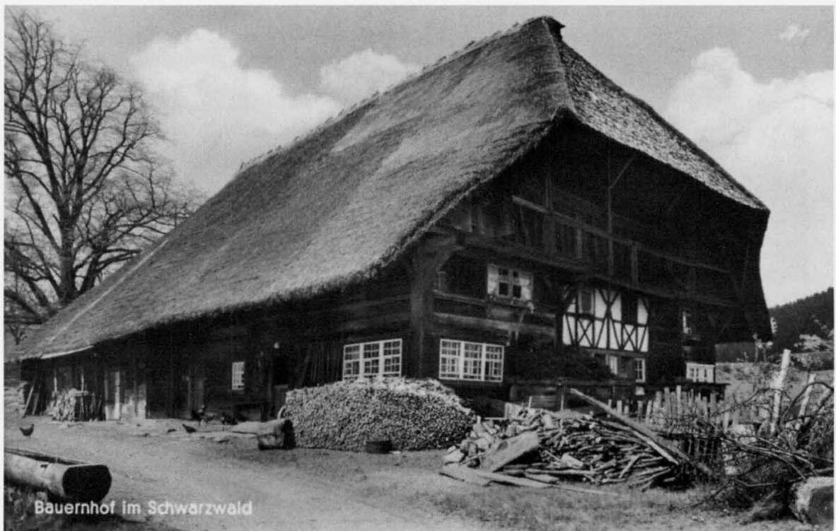
Bild 2: Ein typisches dreiraumbreites Gutachtäler Haus: der 1682 erbaute und am 1. Mai 1956 abgebrannte Vogtsbauernhof in Lauterbach-Sulzbach um 1920. Hinter der hellen Fachwerkwand im Erd- und Obergeschoss der Giebelseite befand sich die Rauchküche.
