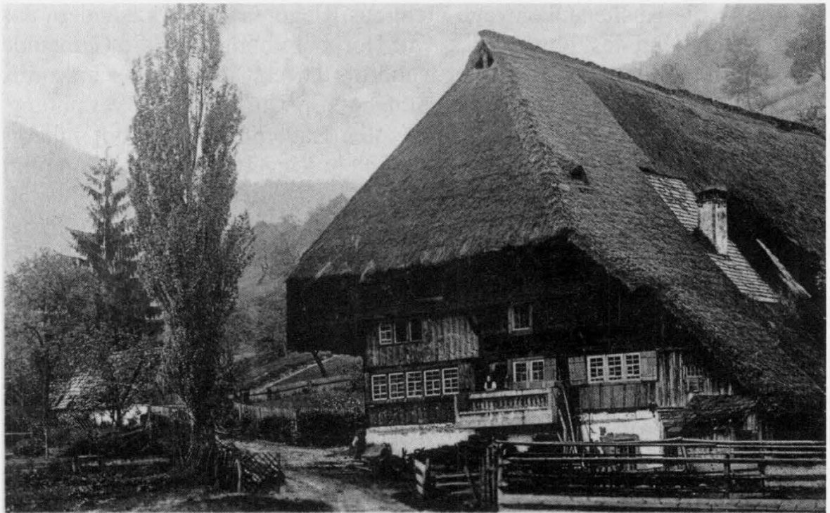
Bild 11: Der um 1758 erbaute Peterbauernhof am Turm in Gutach weist prinzipiell viele konstruktive Gemeinsamkeiten mit dem Laublehof auf – Foto um 1910. Der Wohnungsgrundriss auch dieses an der Frontseite dreiraumbreiten Hauses entspricht nicht dem des typischen Gutacher oder Gutachtäler Hauses nach den Darstellungen von Schilli oder Schnitzer. So beispielsweise befindet sich die Küche nicht an der Giebelseite zwischen den Stuben sondern an der rechten Traufseite des Hauses – ein typisches Merkmal der Kinzigtäler Häuser.
