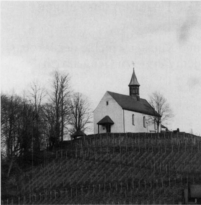
Abb. 1: Jakobuskapelle Gengenbach, Außenansicht mit Eingang, n. d. Restaurierung von 1969/71
